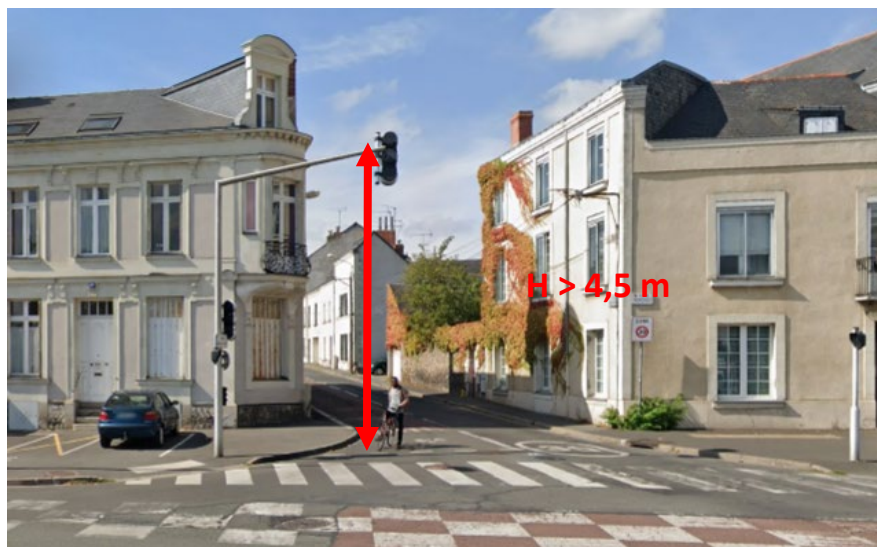
Figura 21: braccio di sostegno – vista generale
