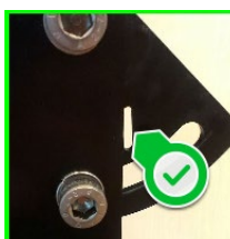
Figuur 10: merkteken voor 45° hoek, achteraanzicht, paal rechts van de baan
